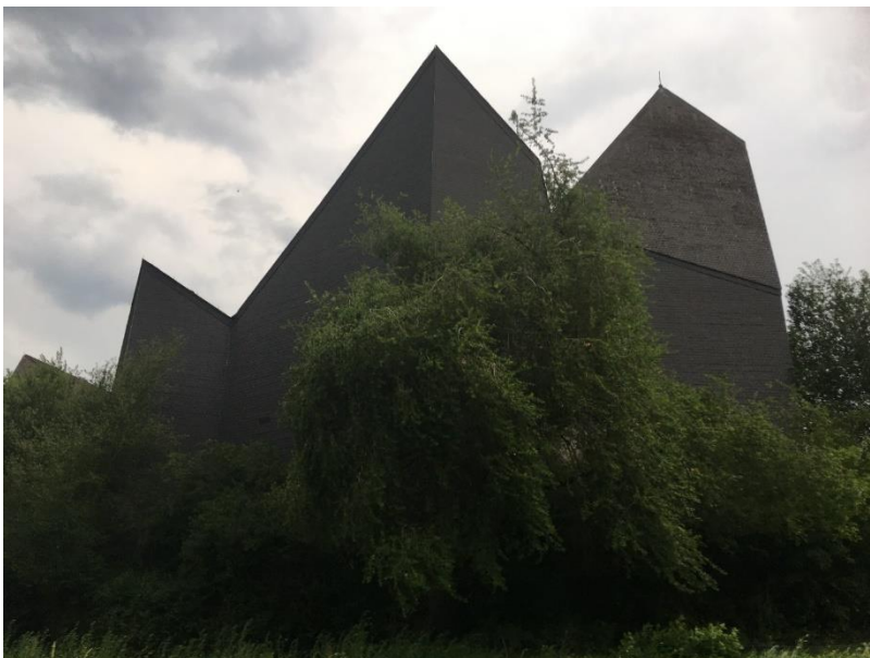
Abb. 2: Aachen-Hanbruch, St. Hubertus, Gottfried Böhm (Foto: S. Lieb)
