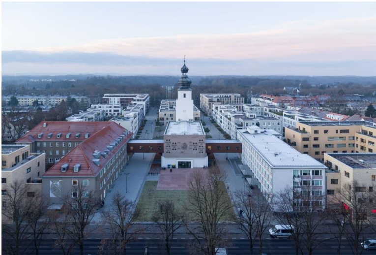
Abb. 3: Köln-Sülz, ehem. Kinderheim-Areal mit Waisenhauskirche, Gottfried Böhm, Umbau durch nebelpössl architekten, Köln (Foto: HG Esch)
