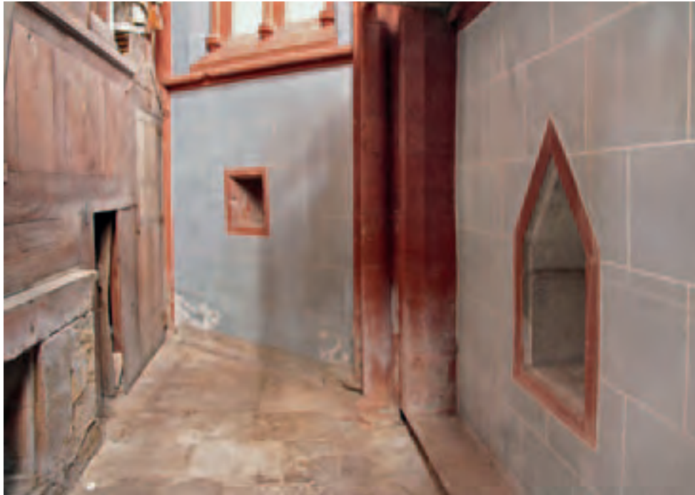
2 Bereich hinter dem Hochaltar der Altenberger Klosterkirche mit nördlicher Sakramentsnische und Nische im Chorscheitel
