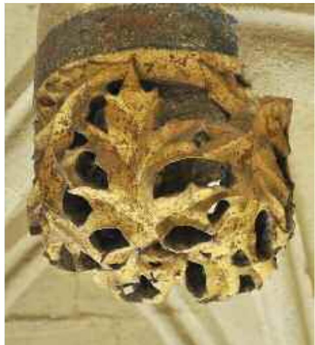
Abb. 4 Naumburg, Dom, Lettnerdurchgang, Schlussstein
