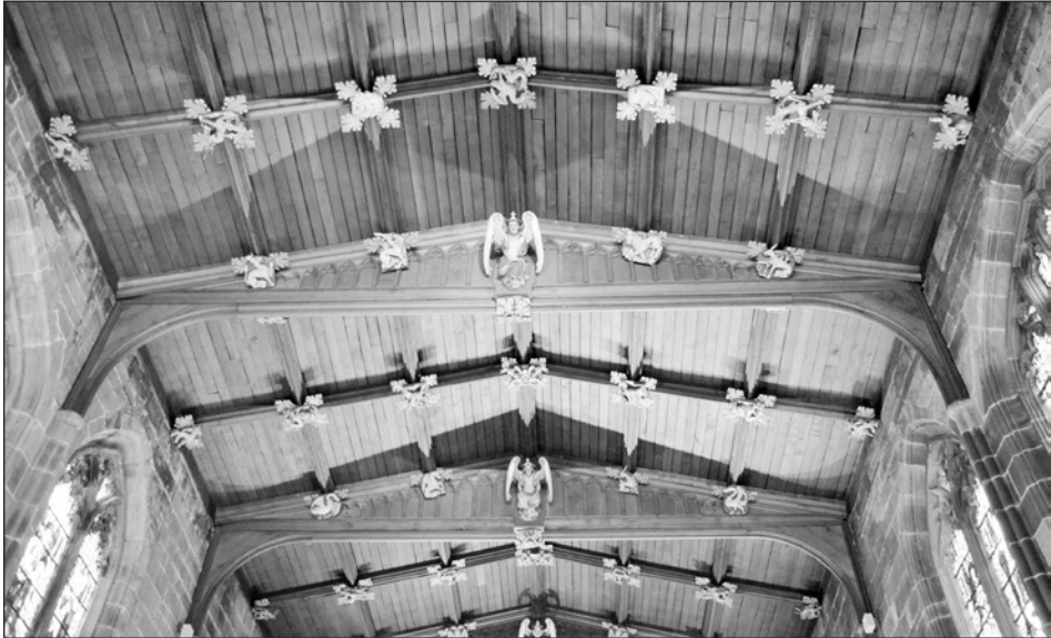
Abb. 9: Holzdecke mit bosses in der St. Mary's Guildhall in Coventry (siehe FT 5, S. 123) Quelle: Mit freundlicher Genehmigung von Melanie Peter
