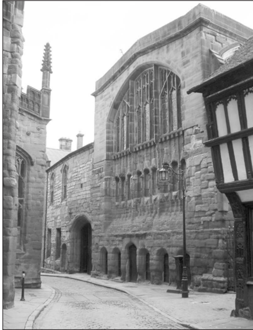
Abb. 5: Nordfassade der St. Marys Guildhall in Coventry
